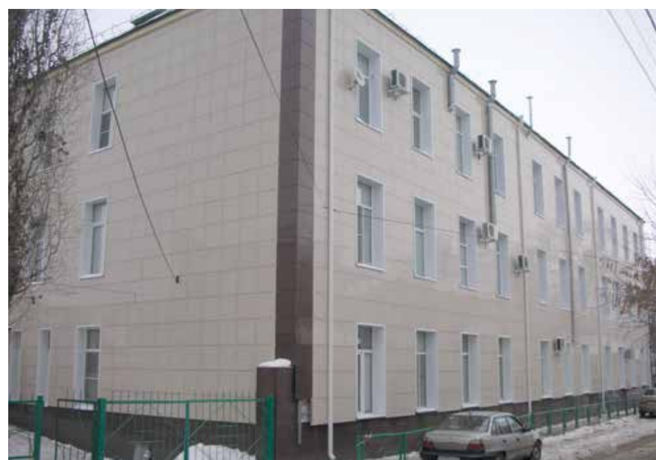
Лечебный корпус № 3 после ремонта
