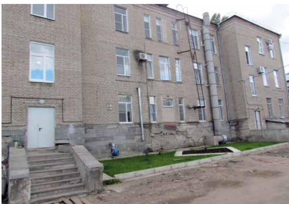
Лечебный корпус № 3 до ремонта
