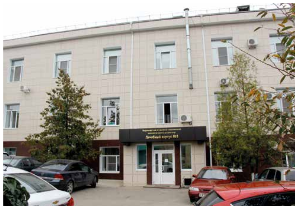
Лечебный корпус № 1 после ремонта
