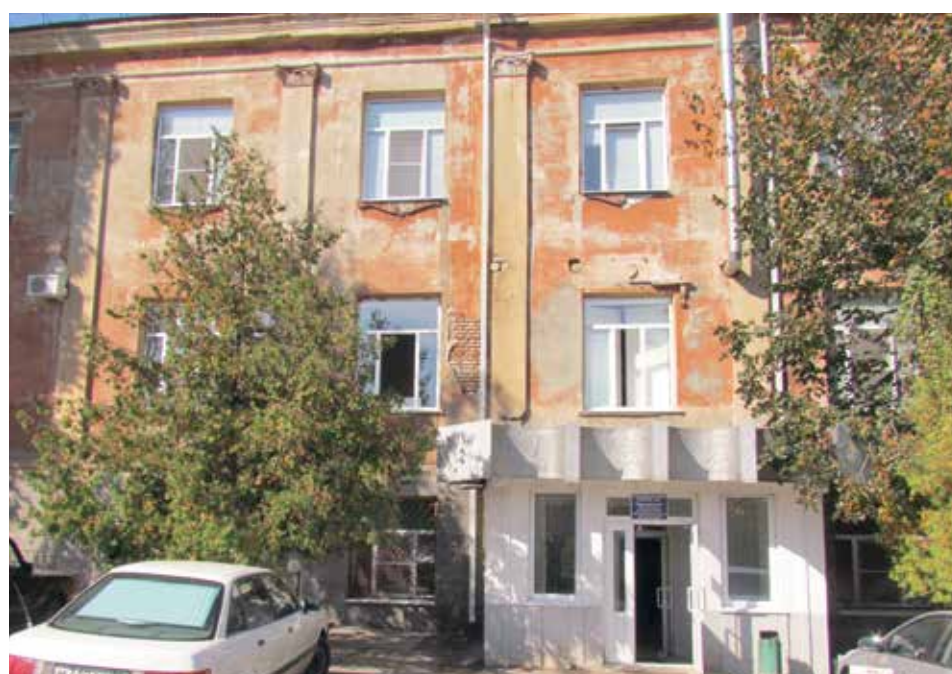
Лечебный корпус № 1 до ремонта
