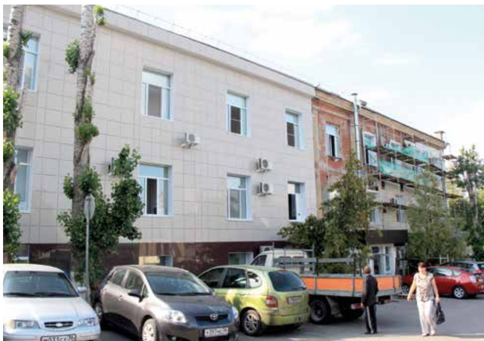
Лечебный корпус № 1 в процессе ремонта
