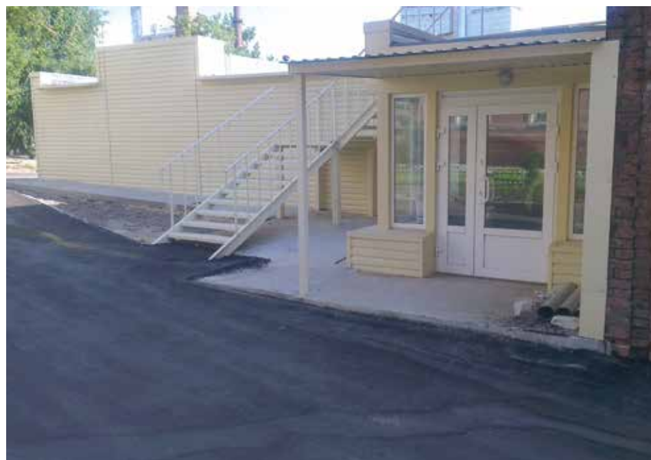
Каньон и прилегающая территория после окончания строительства
