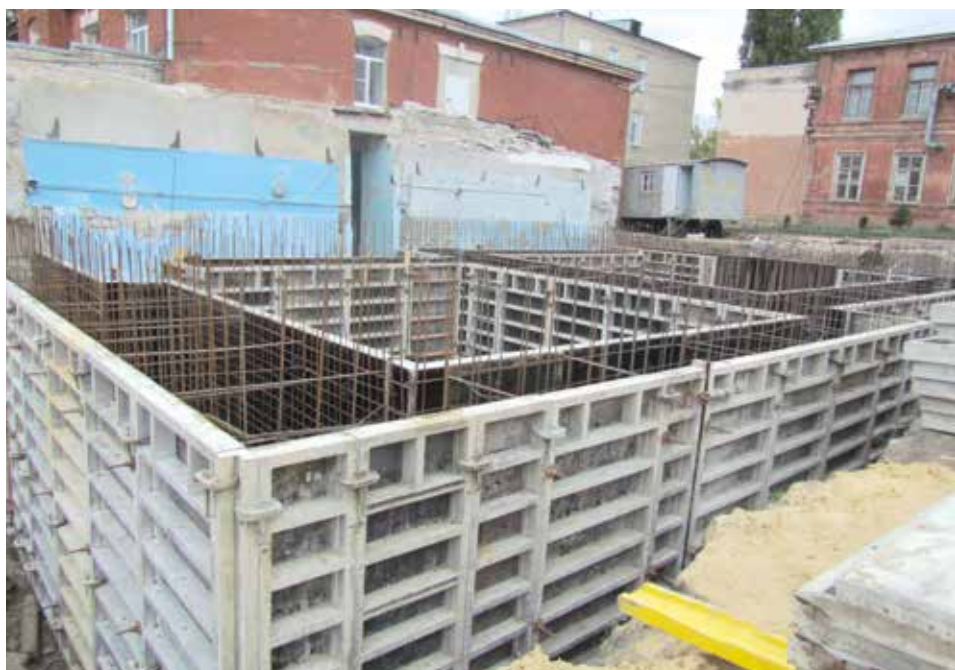
Каньон в начале строительства
