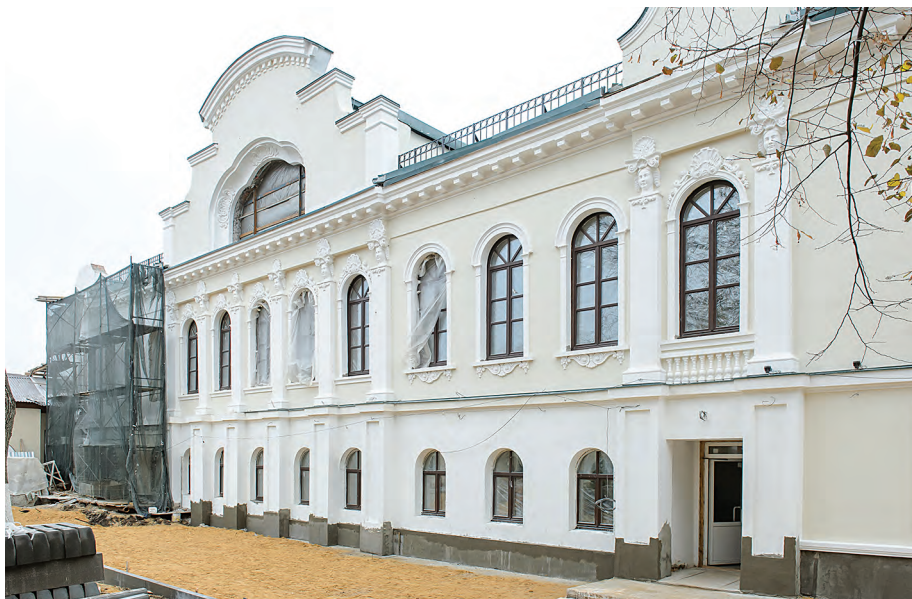
Дом Вигеля в строительных лесах
