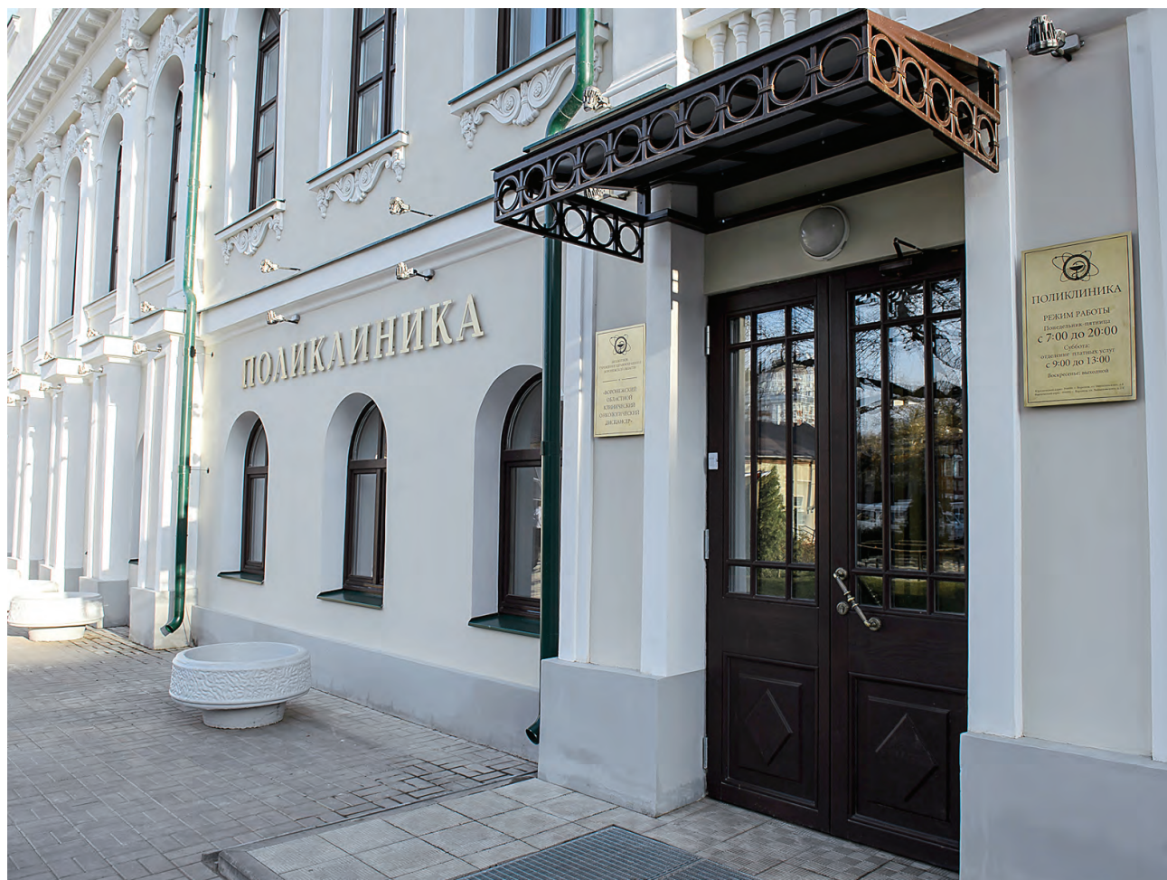
Центральный вход в поликлинику
