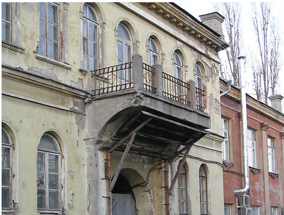
Дом Вигеля до реставрации
