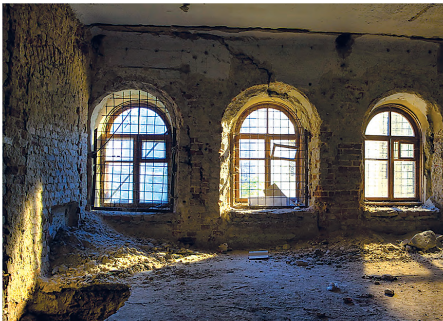
Состояние здания накануне реставрации
